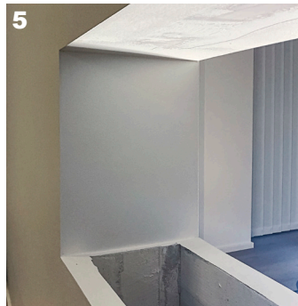
5 Pejsevæg lukket i top og sider / The fireplace wall closed at the top and sides.
